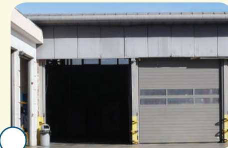
Les garages pour abriter les camions et ranger le matériel
