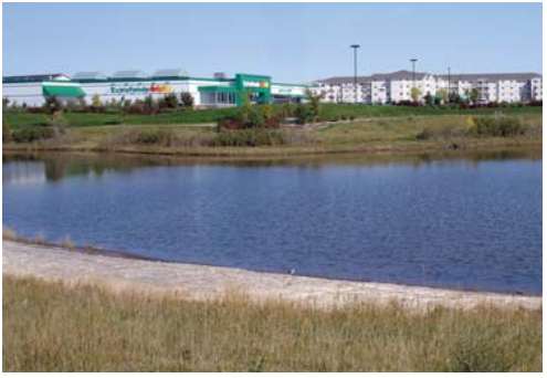
Bassin de rétention, Saskatoon, Canada
