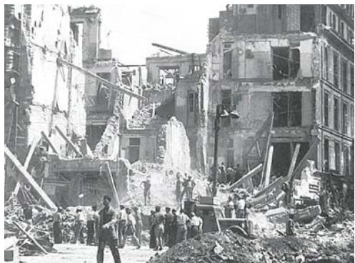
Immeuble de la Canebière détruit en 1944
