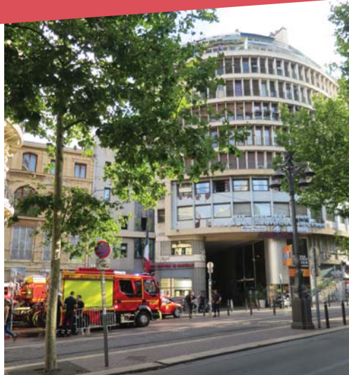
Le building Canebière construit en 1952
