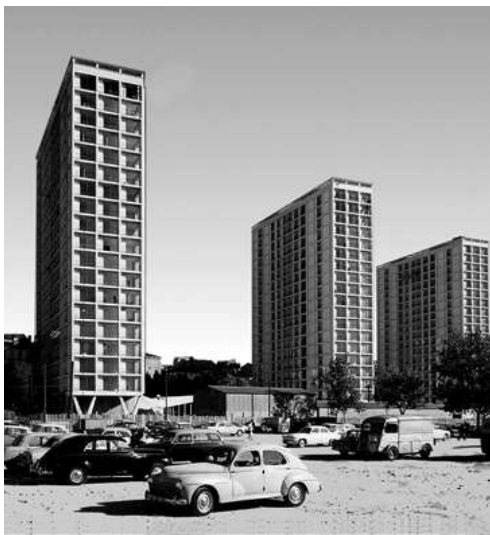
Fin du chantier des Tours Labourdette en 1962
