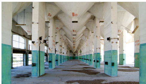
La salle des "mamelles" avant la réhabilitation*
