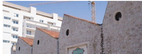
Les sheds de l'ancienne usine Noailles Textiles
