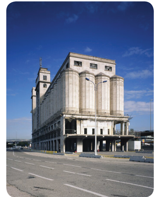
Le Silo de la Joliette en 2011, avant sa réhabilitation*
